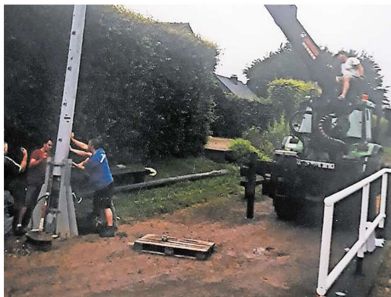
Ein Bild aus alten Tagen: Hier wird das Flutlicht aufgebaut, das aktuell noch den Sportplatz an der Straucher Sonnenstraße beleuchtet und damals in Eigenregie beim FV Vaalserquartier abgeholt und anschließend installiert wurde. Dieses wird im Rahmen des Förderprogramms „Moderne Sportstätten 2022“ in Kürze durch eine moderne Anlage mit LED-Strahlern ersetzt.
