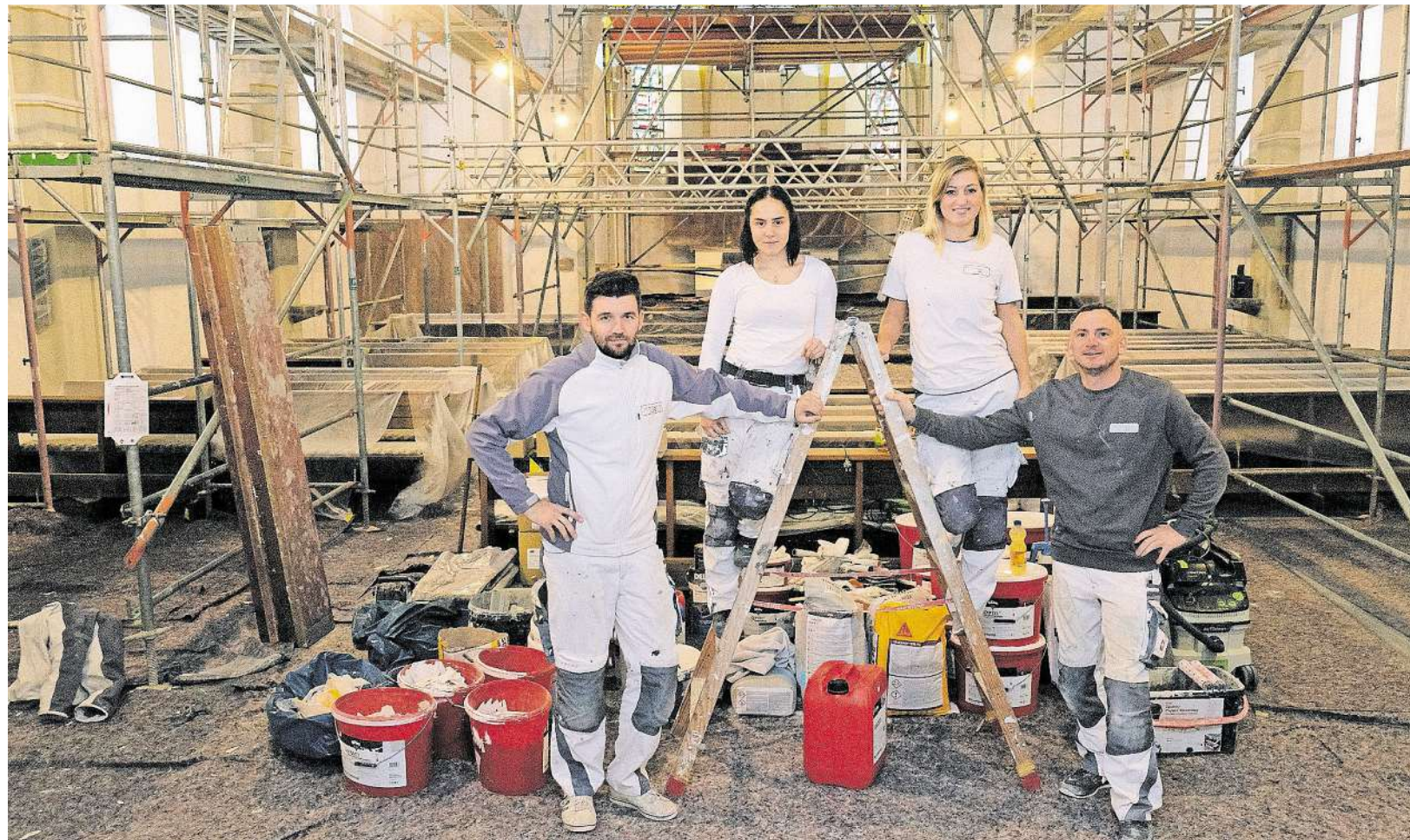
Großbaustelle Gotteshaus: Der Innenraum der Straucher Pfarrkirche St. Matthias wird gründlich saniert. Für rund drei Monate hat das Team des Straucher Malerbetriebs Wunschraum-Liebreich das Kommando übernommen.
